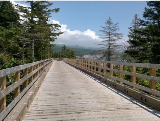
13.3 Passerelle en bois
