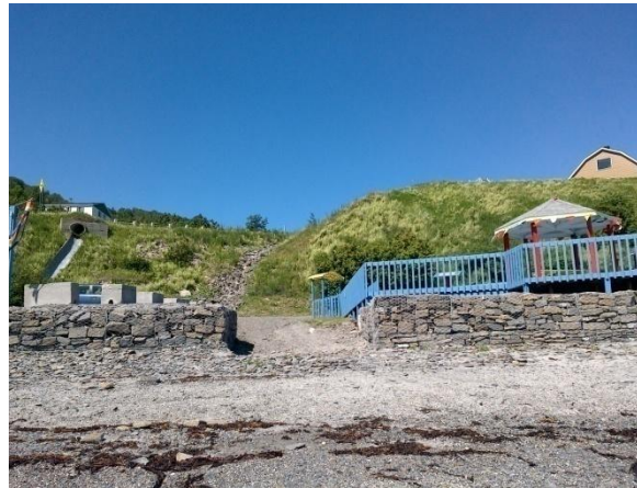
5.4 Rampe de mise à l'eau
