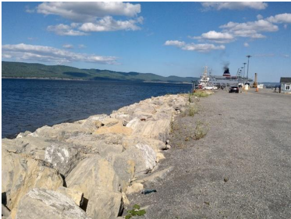
17b.1 Enrochement du quai
