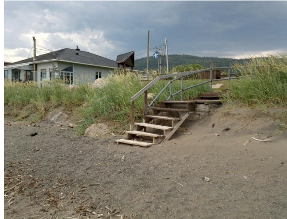
1.2. Accès est avec escalier en bois
