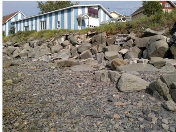
4.14 Enrochement au bas du bâtiment manufacturier
