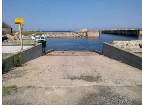
12.2 Rampe de mise à l'eau
