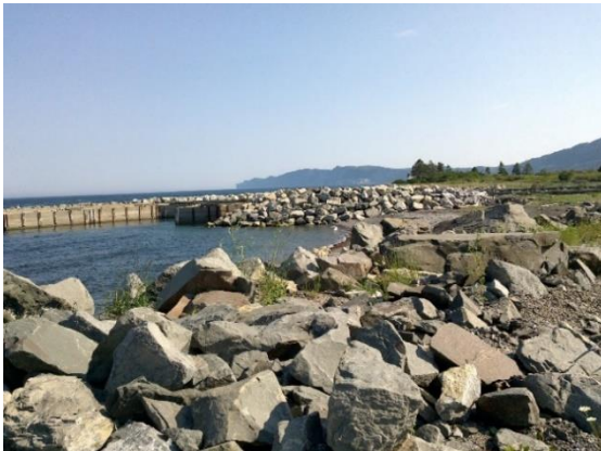
12.3 Enrochement du port du Havre
