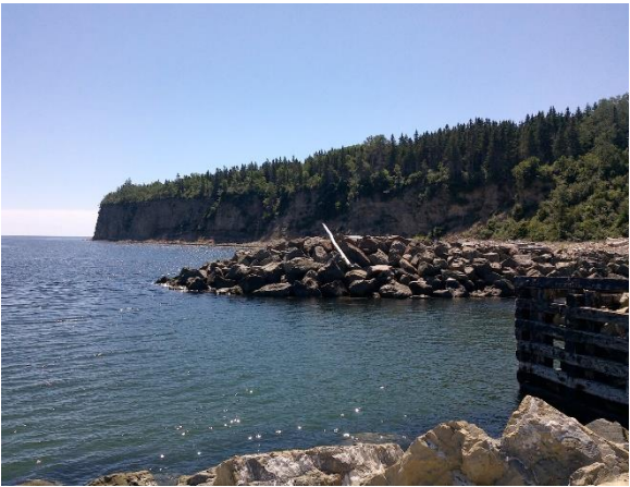
19.3 Les brise-lames à l'entrée du port
