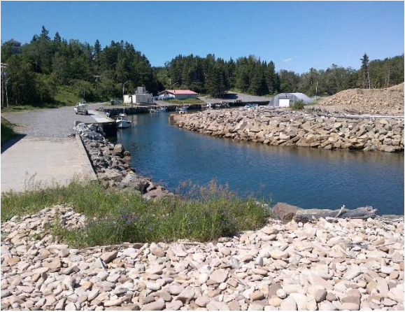
19.1 Entrée enrochée du port
