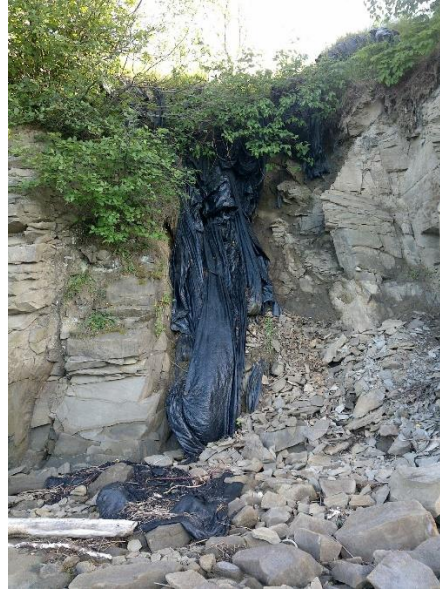
17b.8 Bâche en plastique dans la falaise en érosion
