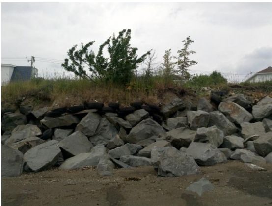
10.9 Enrochement avec des pneus
