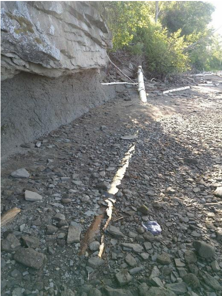
17b.9 Tuyaux en plastique et érosion de la base de la falaise
