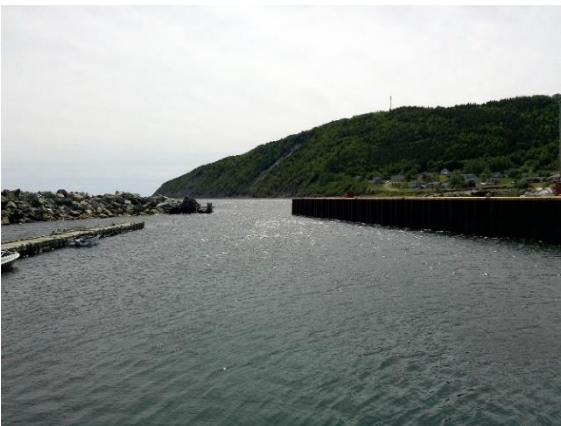
7.5 Brise-lames et ponton du port
