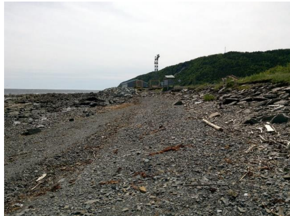
7.4 Enrochement en haut de la plage ouest
