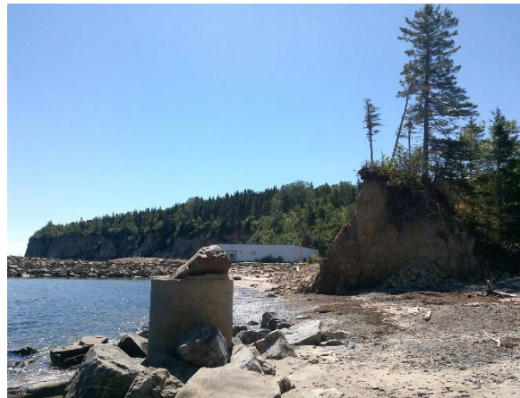
19.10 Cylindre en béton et déchets rocheux sur la plage
