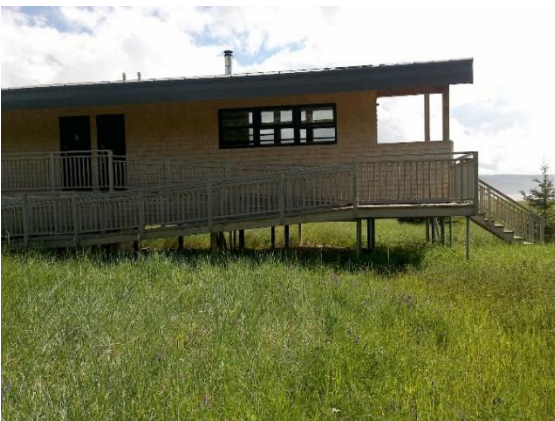
13.5 Bâtiment de service sur pilotis
