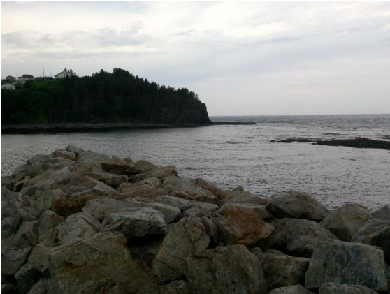
3.1 Vue générale Ouest
