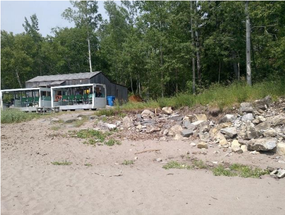
13.1 Enrochement devant la route et bâtiment de location du parc
