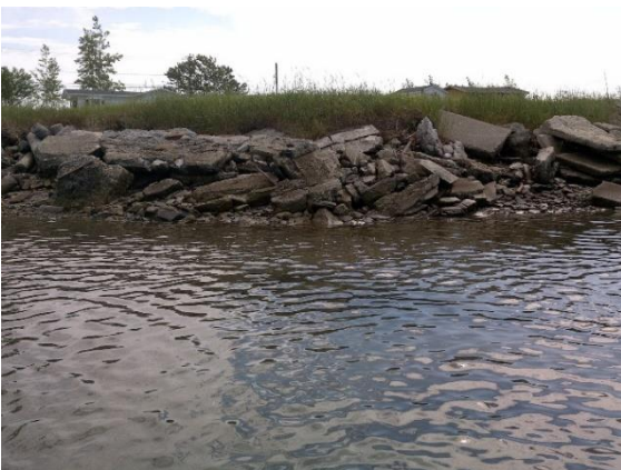
11.11 Enrochement dans le marais
