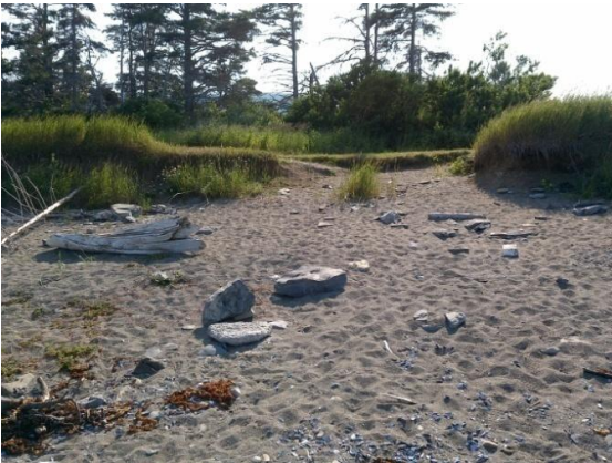
12.9 Érosion de la falaise meuble (plage sud)
