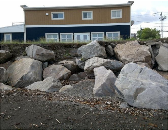
1.7. Enrochement devant les bâtiments
