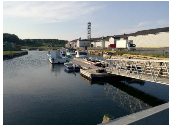
11.4 Havre de pêche de l'Anse-au-Griffon et l'usine La crevette du Nord Atlantique Inc.
