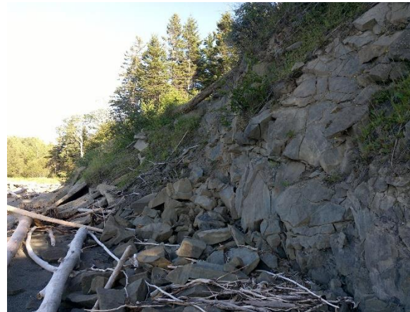
17a.8 Falaise rocheuse en érosion
