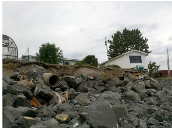
10.8 Enrochement avec filets de pêche et sorties d'eau
