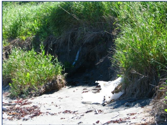
B- Érosion et décrochement de talus
