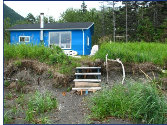
B- Érosion et décrochement de talus
