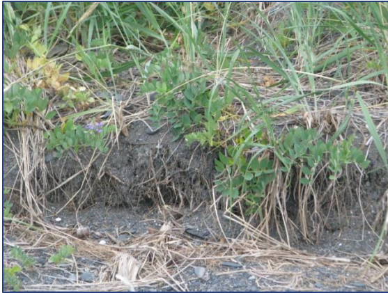
A- Érosion de la côte
