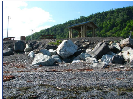
B- Érosion de la halte routière
