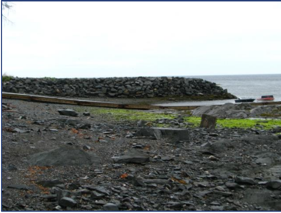
A- Quai flottant et enrochement
