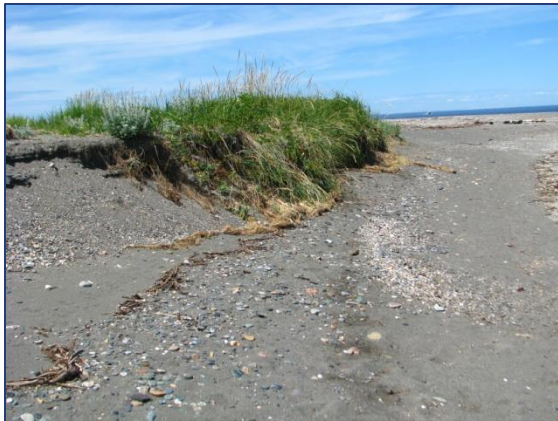
A- Érosion de la côte
