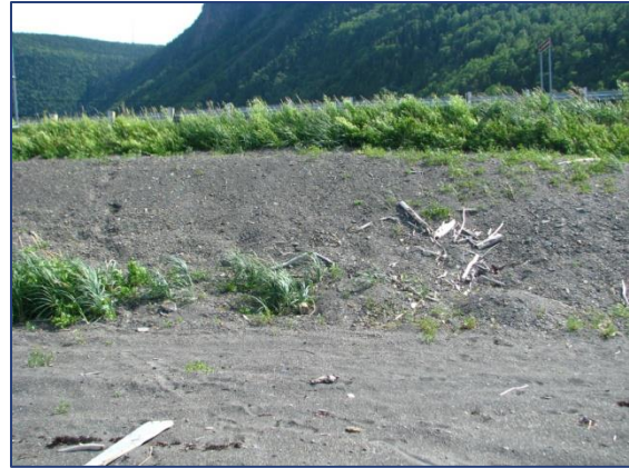
B- Érosion du talus
