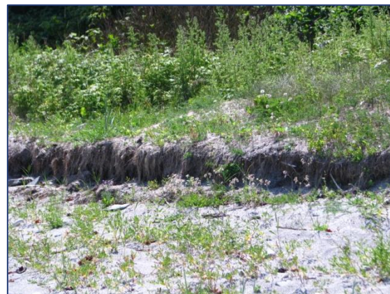
B- Érosion et décrochement du talus
