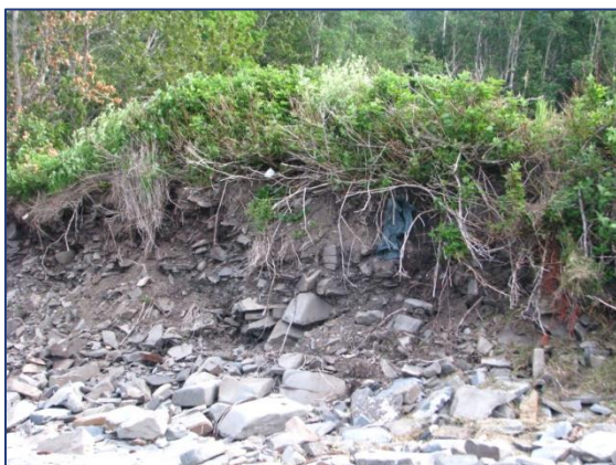
A- Érosion et décrochement de talus
