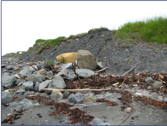
A- Érosion et décrochement de talus
