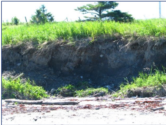
A- Érosion et décrochement de talus
