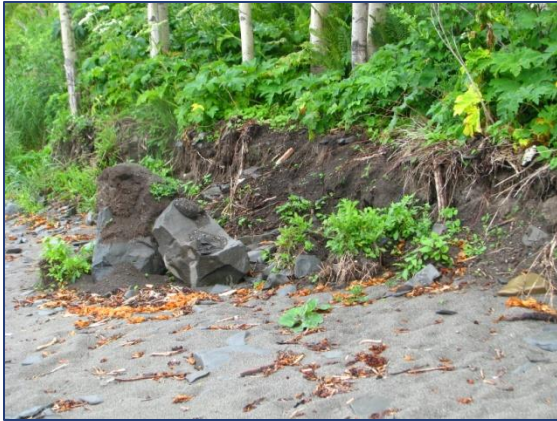
A- Érosion et décrochement de talus
